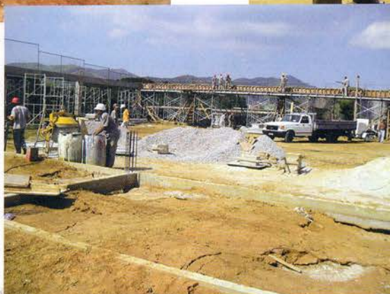
Visão geral do local onde está sendo construído o ginásio
